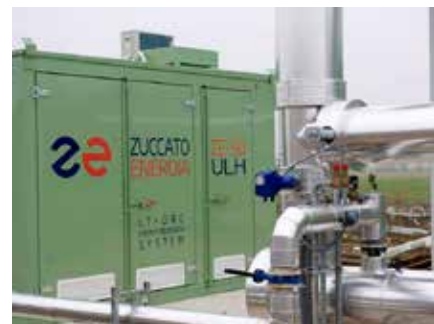
Borgoforte (MN) - Recupero termico da camicie e fumi di scarico di gensets a biogas
