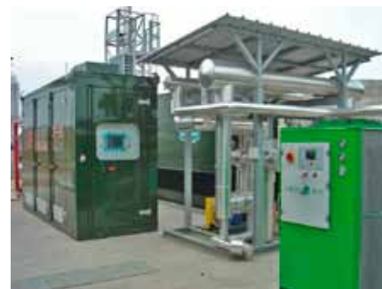
Portogruaro (Veneza, Itália) - Recuperação de calor a partir de jaquetas de refrigeração e escapamentos dos motores a biogas
