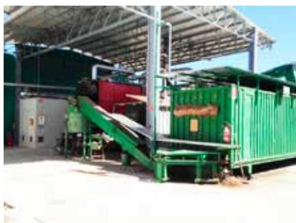
**Sommalombardo (VA)** - Produzione elettrica da caldaia alimentata a biomassa (scarti di segheria)
