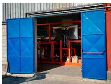
Castrovillari (CS) Produzione elettrica da caldaia alimentata a biomassa (sfalci di potatura)
