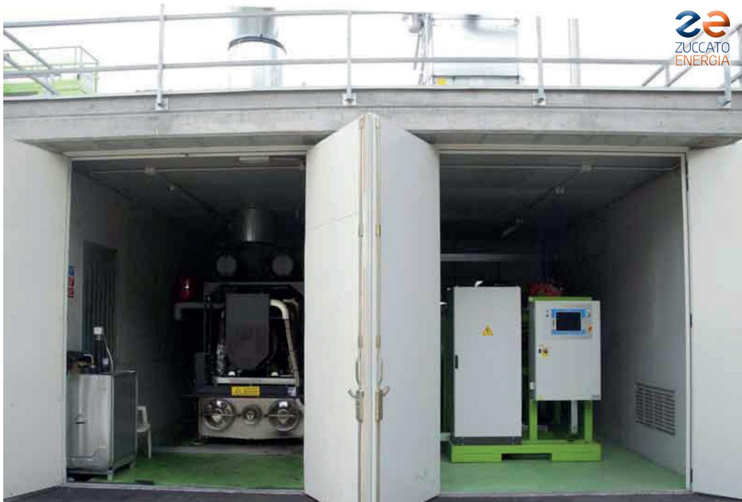
*Alto Adige 01 / Bolzano: Il motore ad olio vegetale (a sinistra) ed il modulo ORC ZE-50-ULH (a destra) nel loro shelter in cemento.*
