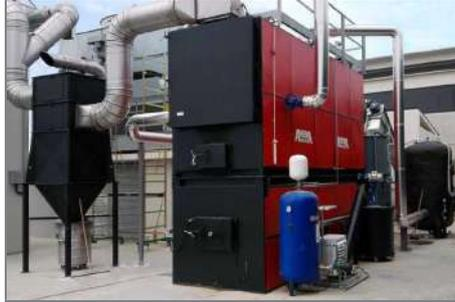
*La caldaia a griglia mobile da 1300 KwT alimentata a cippato*
