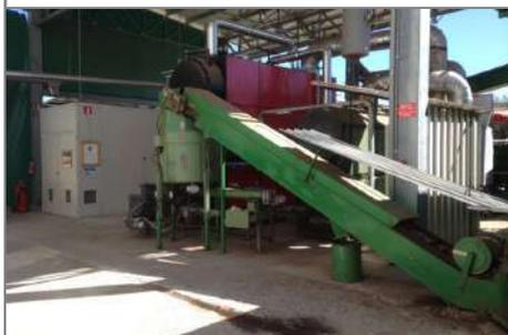
Dettaglio del convogliatore del cippato alla caldaia. Sul fondo lo skid.
