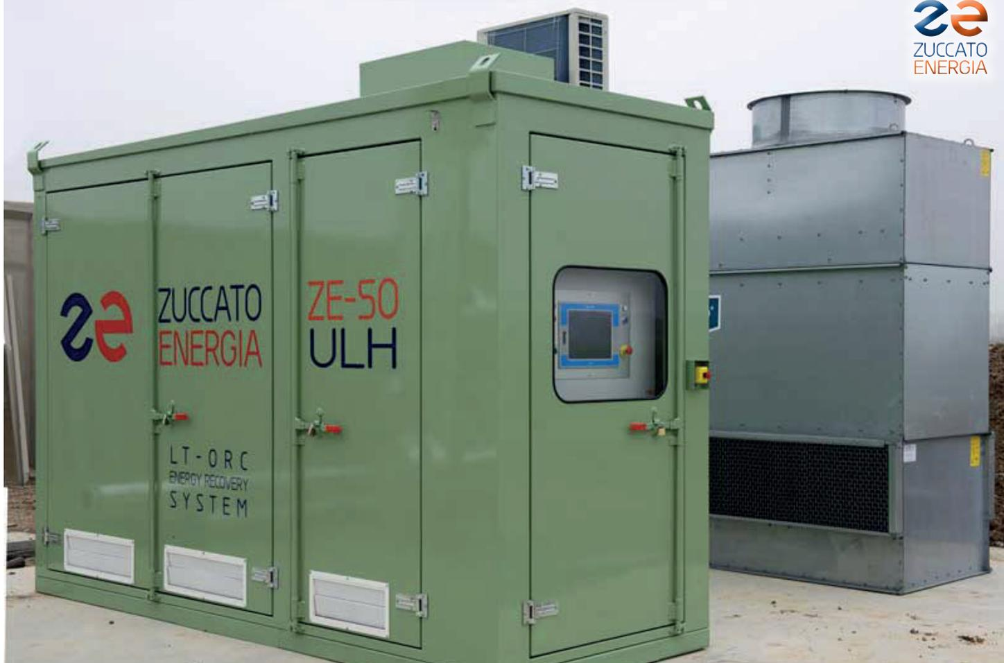
*Lombardia 01 / Mantova: Il modulo ZE-50-ULH containerizzato a prova di intemperie; sullo sfondo, la torre di raffreddamento.*
