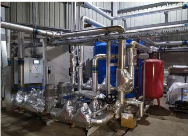
*Sistema di preriscaldamento della caldaia e acqua surriscaldata dell'ORC.*
