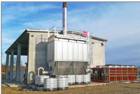
*Il sistema di trattamento fumi e la ciminiera. A destra, il dry cooler.*
