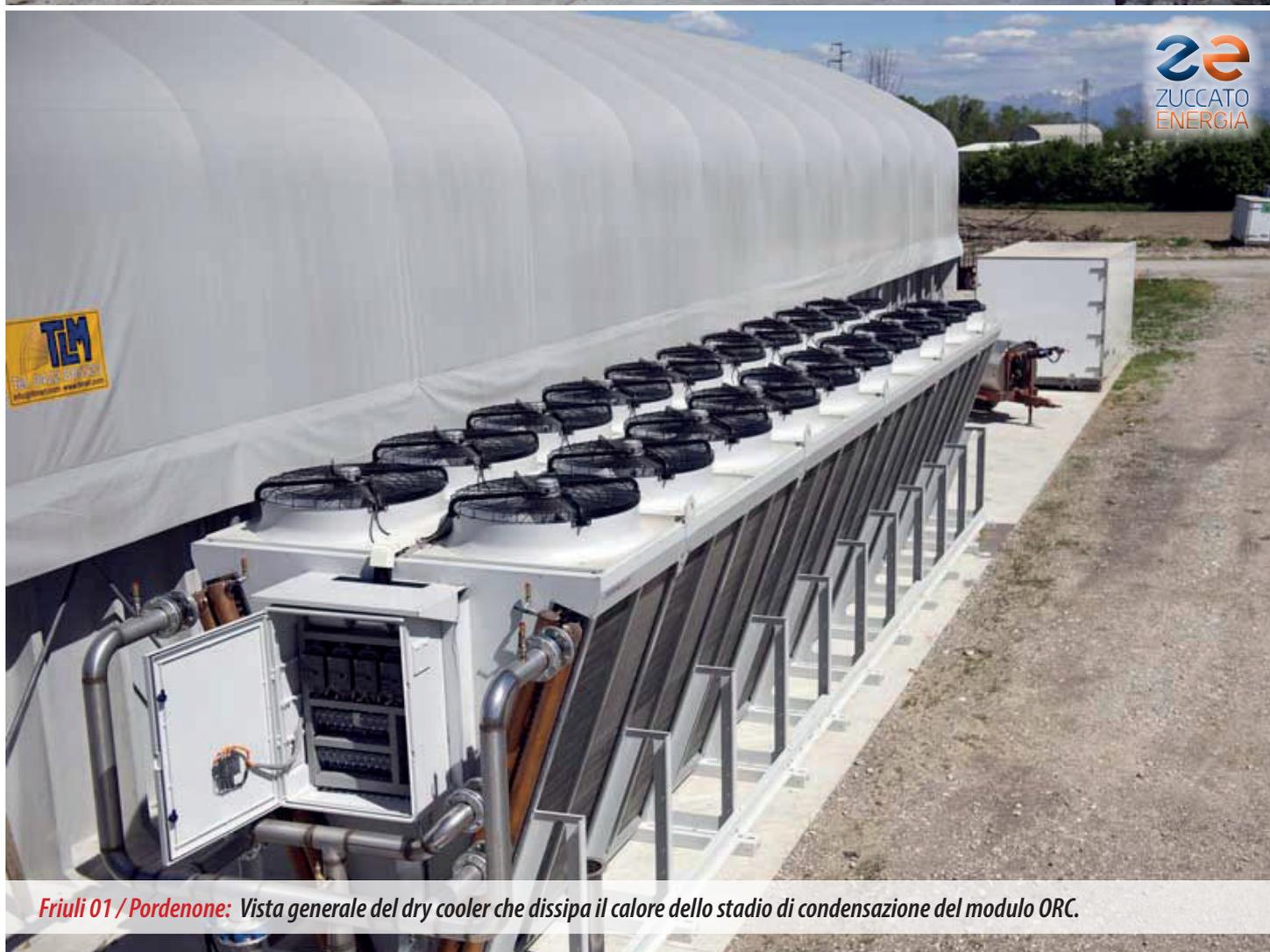
*Friuli 01 / Pordenone: Vista generale del dry cooler che dissipa il calore dello stadio di condensazione del modulo ORC.*
