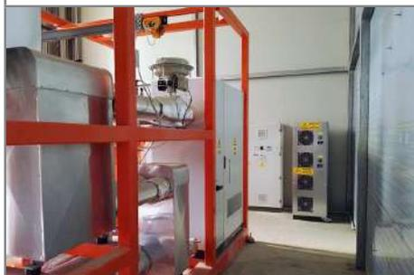
Lo skid e sullo sfondo l'armadio delle resistenze di frenatura
