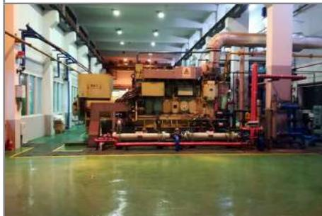
*Il motogeneratore diesel dai cui fumi viene effettuato il recupero termico.*
