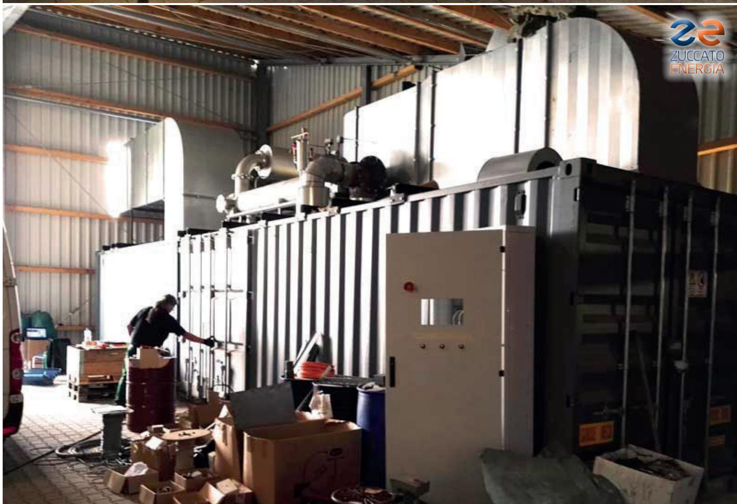
*Germania 02 / Bassa Sassonia: Il container che ospita il motogeneratore MAN alimentato a biogas.*
