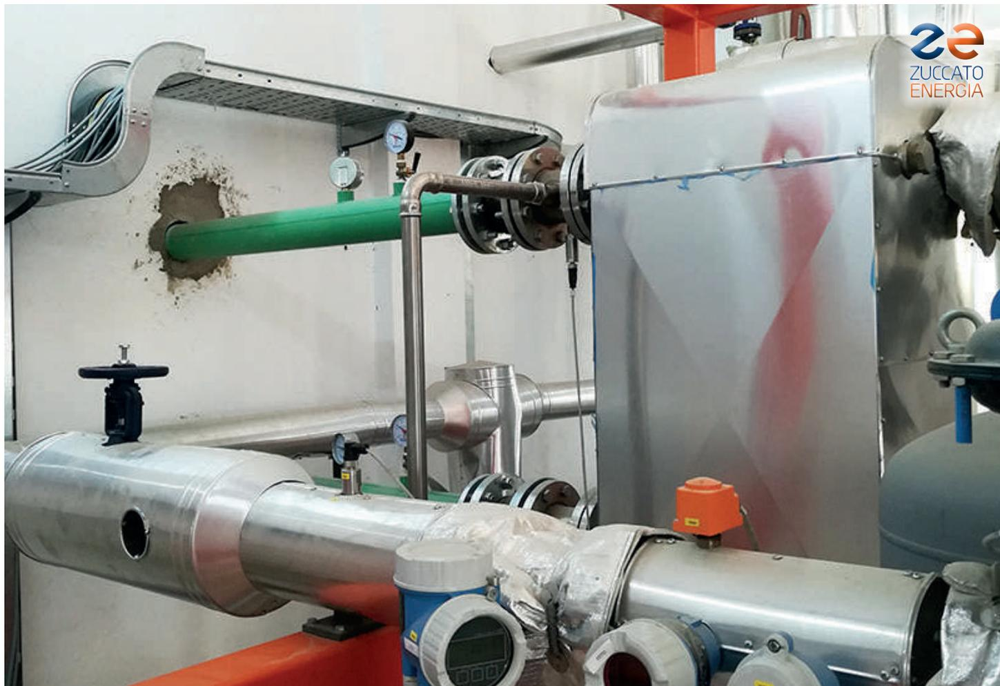
**Tunisia 01** : Gli scambiatori di calore. Questo impianto è il primo di ZE ad utilizzare vapore come fluido vettore.
