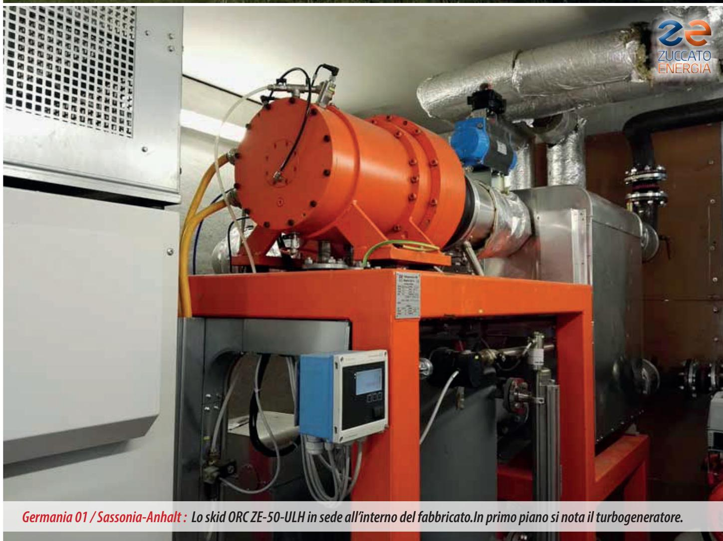
*Germania 01 / Sassonia-Anhalt: Lo skid ORC ZE-50-ULH in sede all'interno del fabbricato. In primo piano si nota il turbogeneratore.*
