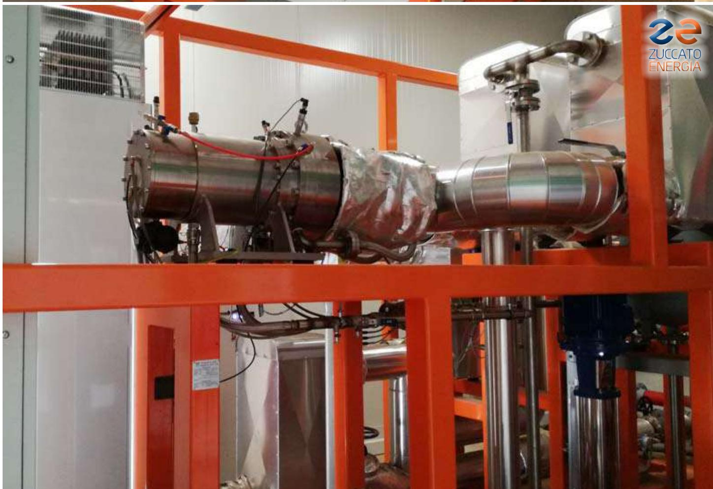
*Lombardia 03 / Brescia: Un dettaglio dello skid che mostra il turbogeneratore (cilindro metallico al centro).*
