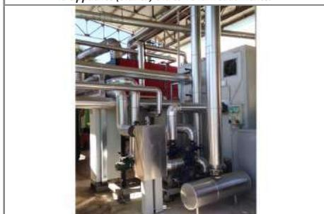
Dettaglio degli allacci termici alla caldaia, interamente coibentati
