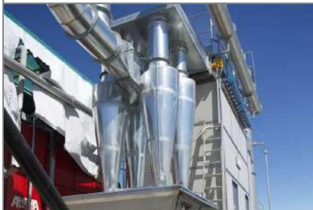
L'impianto trattamento fumi con la copertura rimossa per mostrare i cicloni di filtraggio
