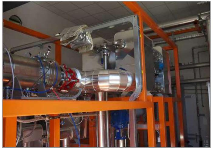
*Il sistema ORC ZE-150-LT in dettaglio con in primo piano la turbina*
