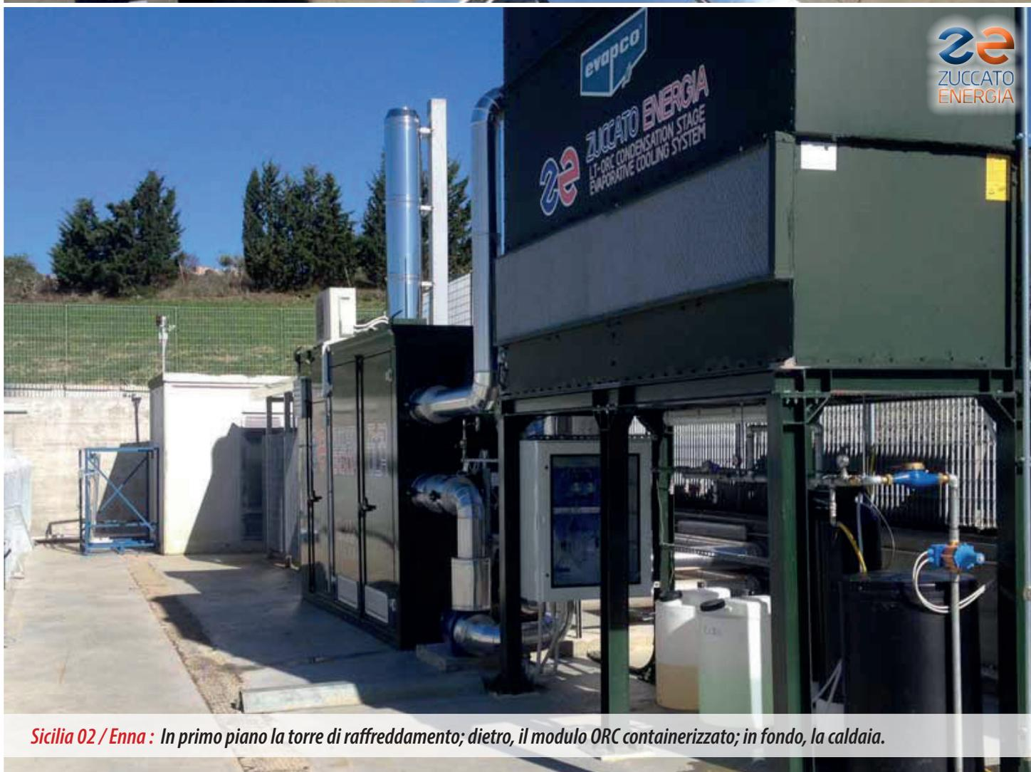
*Sicilia 02 / Enna : In primo piano la torre di raffreddamento; dietro, il modulo ORC containerizzato; in fondo, la caldaia.*
