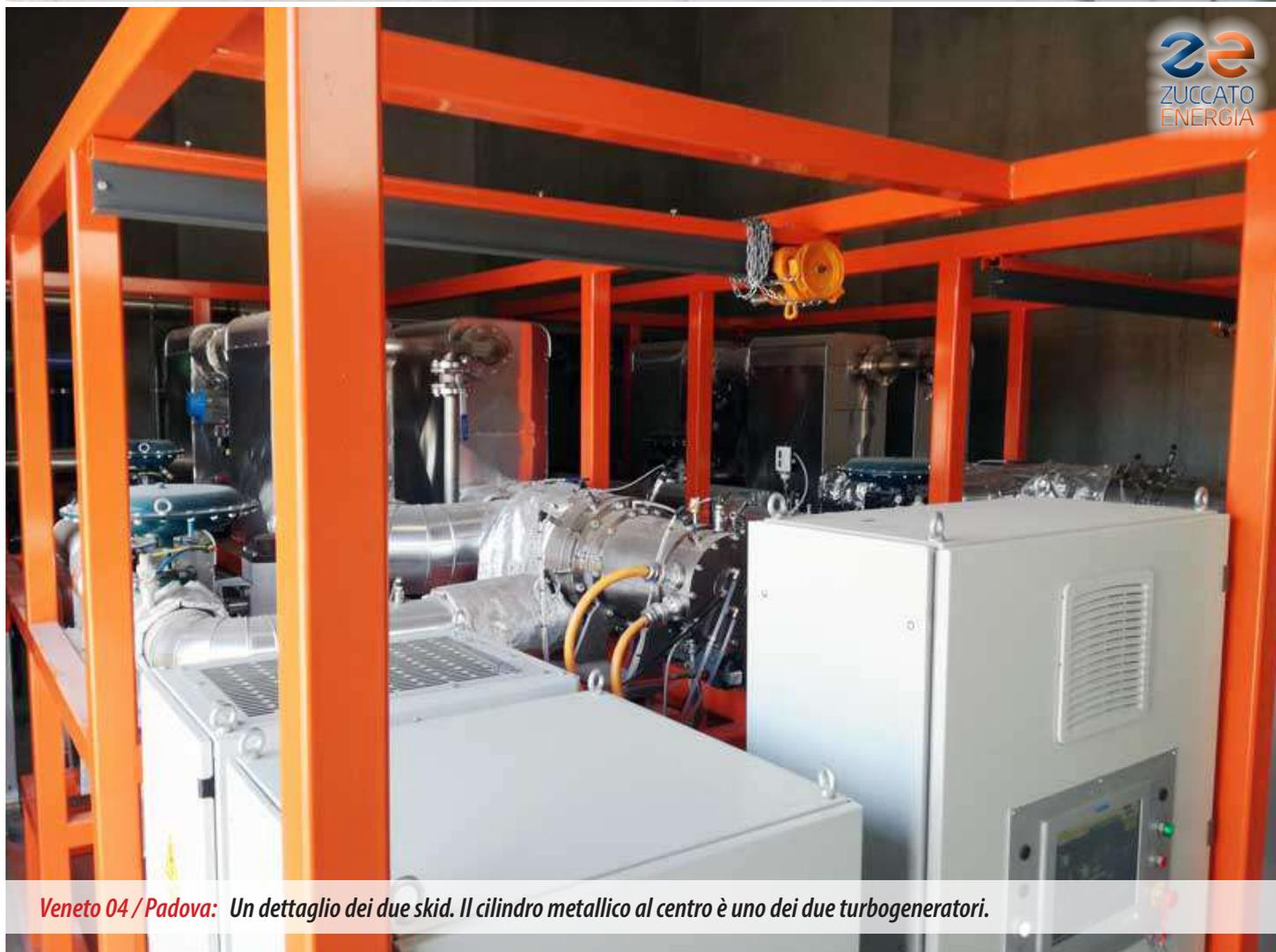
*Veneto 04 / Padova: Un dettaglio dei due skid. Il cilindro metallico al centro è uno dei due turbogeneratori.*
