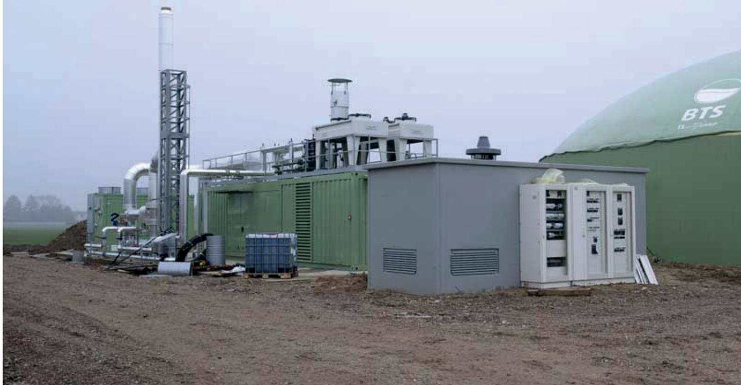
*Lombardia 01 / Mantova: Vista generale dei fermentatori, dei motori e del modulo ORC ZE-50-ULH containerizzato.*
