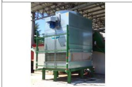
La torre di raffreddamento: parte del calore residuo viene usato per essiccare il cippato.
