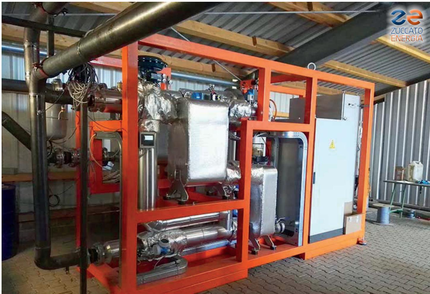
*Germania 02 / Bassa Sassonia: Il modulo ORC ZE-40-ULH visto dal lato delle connessioni idrauliche.*
