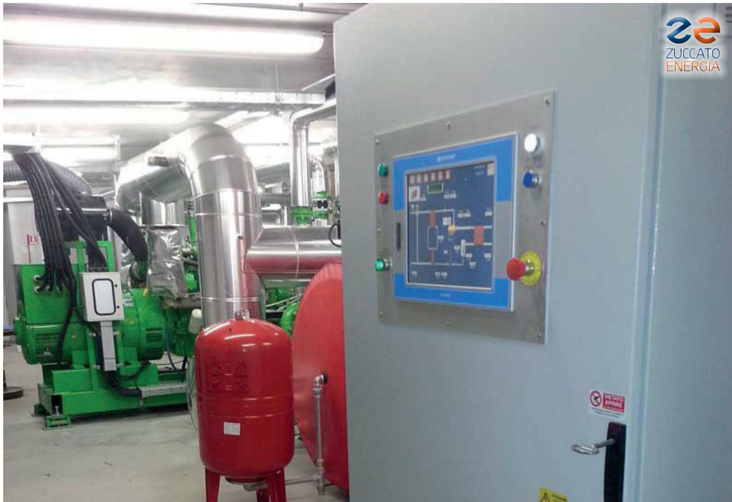
*Aosta 01 / Aosta: Vista generale della sala caldaie - motore (verde), buffer termico (rosso) e modulo ORC (bianco)*
