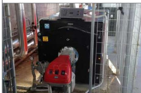
La caldaia ICI che fornisce la maggior parte dell'energia termica all'impianto
